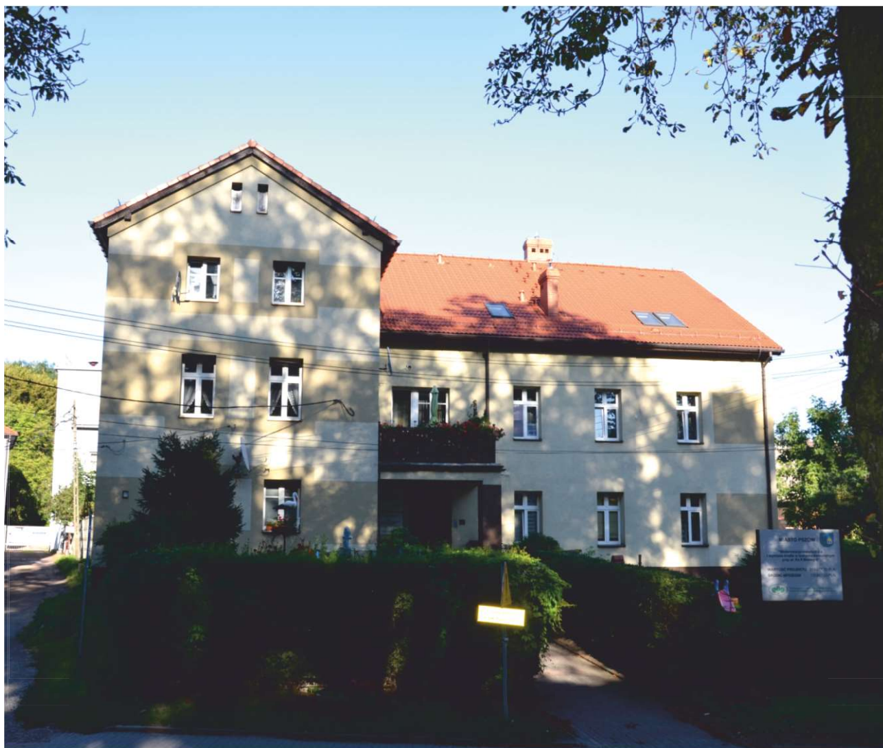
Obecnie budynek po dawnej szkole jest budynkiem komunalnym gminy Pszów
